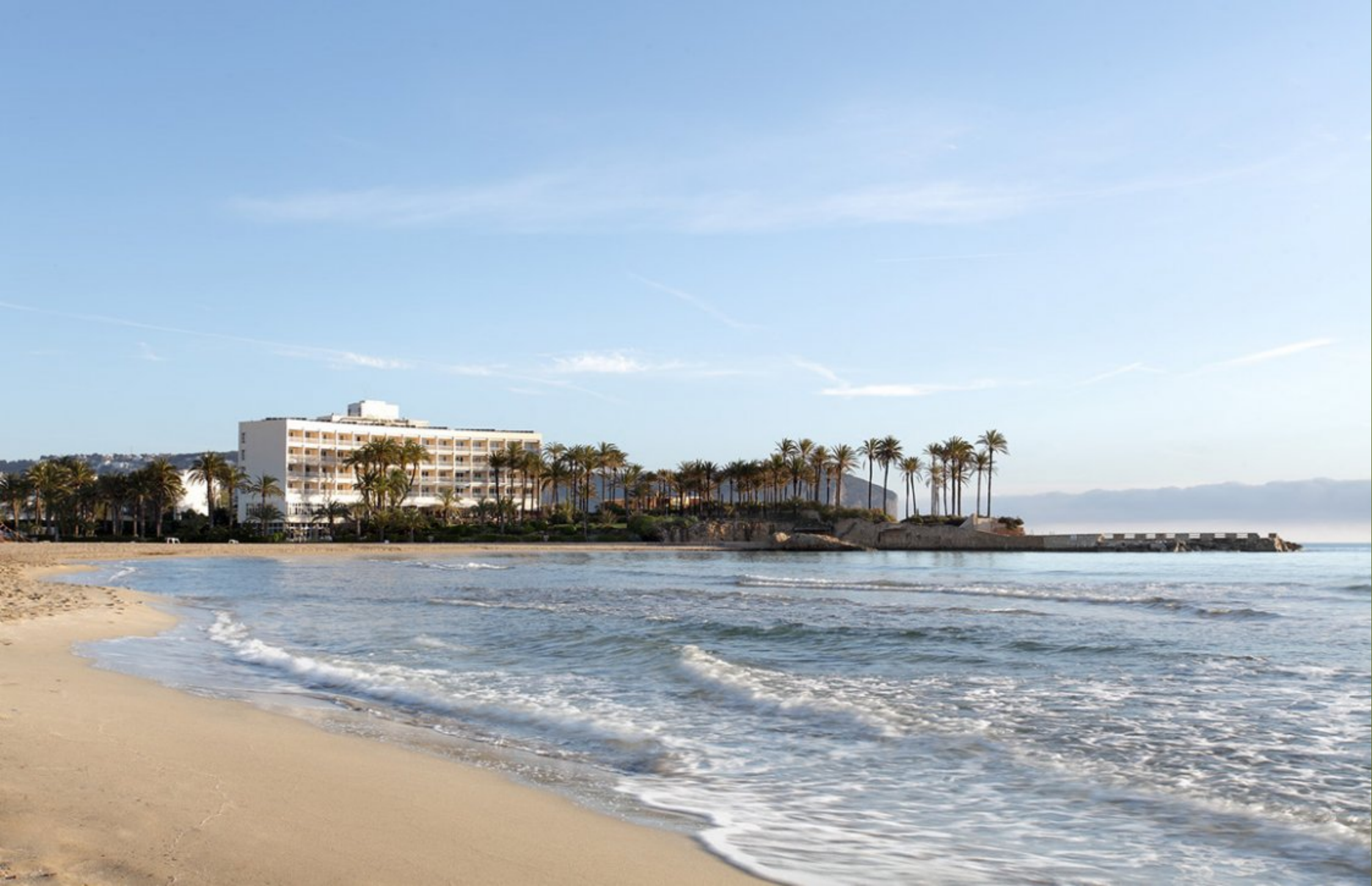
Parador de Jávea Surroundings
